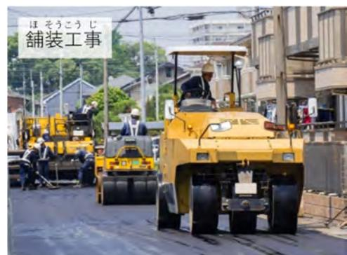
事故が起こります。また、舗装道路の補修工事などでは、バックホウのアームやバケットとの接触事故も起こります。道路工事は、建設機械と人が、接近して作業を進めるのが特徴です。建設機械の操作員と合図しながら作業員の安全を確保する誘導員を配置しますが、作業員自身も周囲の安全に常に気を配らなくてはいけません。
