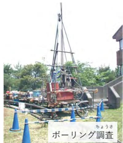
装置でくみ上げます。掘削とくみ上げを繰り返しながら、帯水層まで掘り進めます。
