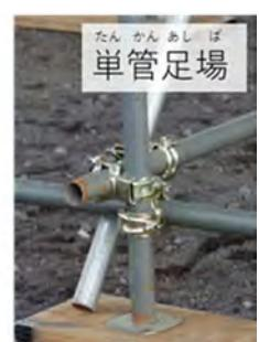
**【筋交】**構造を補強し、風などで足場が倒れないようにするための部材です。支柱と支柱の間に、斜めに入れます。
