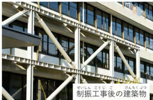
・制振工事…建物の揺れを制御するために、建築物にダンパーなどのエネルギー吸収機構を取り付けます。
