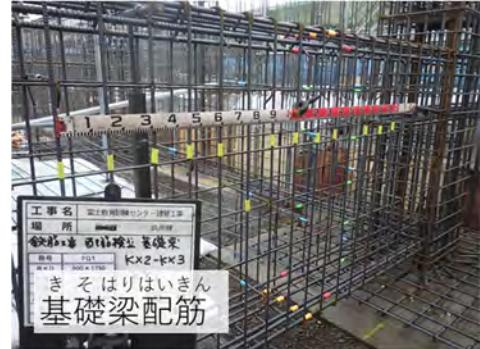
ベース配筋の次は、柱の配筋を行ないます。柱は、地面に対して垂直に配置された主筋と、主筋を囲うフープ筋(帯筋)で構成されます。柱筋とフープ筋の結束が完了したら、かぶり厚さを確保するために、スペーサーを取り付けます。柱筋の次は、梁筋の配筋を行ないます。すべての基礎配筋完了後は、型枠の建込み→基礎コンクリート打設が行われます。
