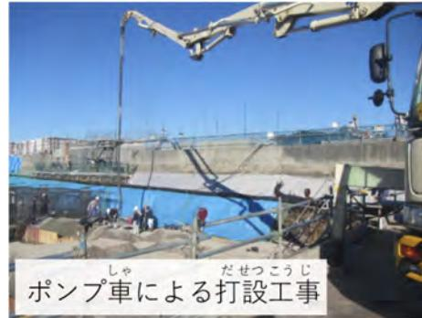
工事中に気をつけなければならないのは、ブームの移動による電線との接触や切断です。安全離隔距離（電線から離す距離）を確認し、これを守ります。輸送管の点検と接続の確認も大切です。打音（叩いたときの音）や、超音波厚さ計で、日常的に点検しておきます。
