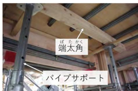
**【パイプサポート】** 梁の底板や床型枠の大引き受けに使用される部材です。圧縮力を負担します。
