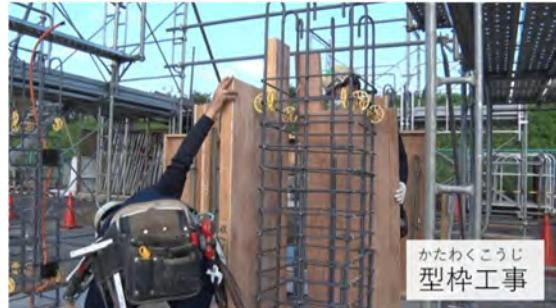
きな圧力が加わります。この圧力に耐えられないと、型枠が壊れてコンクリートが流
