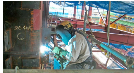
လျှပ်စစ်မီးတောက်ဖြင့်ဂဟေဆော်ခြင်း (arc welding)အလုပ်
