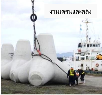
งานเครน (งานถมหินสำหรับถมไต้่น้ำ)
