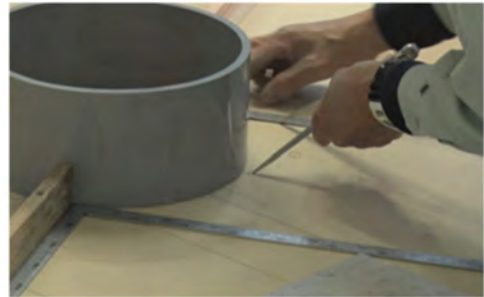
丸柱部分の墨つけ
