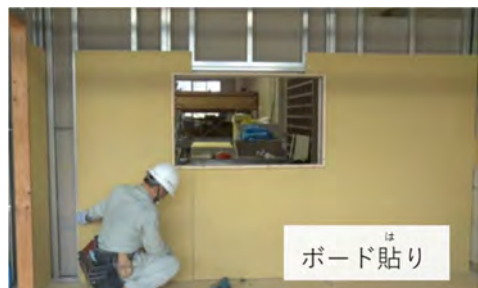
鋼製下地工事
