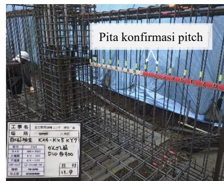
Untuk menjaga kekuatan, perlu menggunakan rebar dengan ketebalan yang ditentukan dan menyusun rebar dengan jarak yang benar di antaranya. Pita dililitkan di sekitar rebar untuk memudahkan memeriksa pitch.
