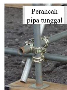
secara fleksibel sehingga perancah dapat dipasang di ruang sempit sekalipun. Dalam hal kekuatan dan keselamatan, beberapa bagian kekuatan dan keamanannya lebih rendah daripada perancah kerangka, dan material ini terutama digunakan sebagai perancah untuk mengecat dinding eksterior bangunan bertingkat rendah. Material dasar mencakup pipa tunggal, alas tetap, klem, braket pipa tunggal, papan perancah, sambungan, dll.
