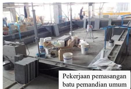
pekerjaan seperti konstruksi eksterior, yaitu seperti dinding luar, dinding dalam, lantai, kamar mandi, pintu masuk, taman, dll. dalam pekerjaan dinding luar, ada dua metode yaitu “metode konstruksi basah” di mana material batu seperti marmer, granit, dll. ditempel dengan mortar, dan “metode konstruksi kering” di mana material batu dikencangkan pada perangkat logam seperti jangkar baut, dll. yang dipasang pada kerangka.
