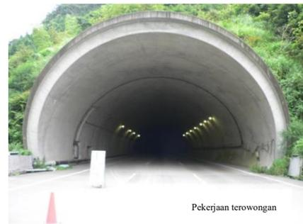
**[Terowongan gunung]** Terowongan gunung adalah metode konstruksi terowongan yang terutama menggali batuan keras di daerah pegunungan. Metode konstruksi yang disebut NATM digunakan, di mana terowongan digali dengan peledakan atau mesin penggali terowongan, dll. lalu dipasangi shotcrete, penopang baja, dan baut batuan pada permukaan yang digali.
