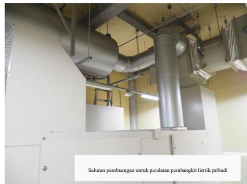
luar. Dalam pekerjaan saluran, pelat logam diproses sesuai dengan lokasi pemasangan dan dilakukan pekerjaan pemasangan.
