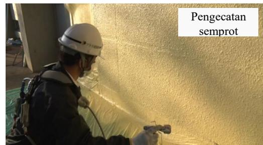
Jangan lupa untuk merawat bagian-bagian yang tidak dicat karena pengecatan dilakukan hanya untuk bagian-bagian yang diperlukan. Tutupi lantai dengan curing poly sheet, tempelkan masking tape pada batas bagian yang dicat dan tidak dicat lalu rawat dengan masker pada daerah yang luas seperti dinding, dll. Selain itu, saat mengecat dinding luar, cat dapat memercik di dekatnya dan menempel pada
