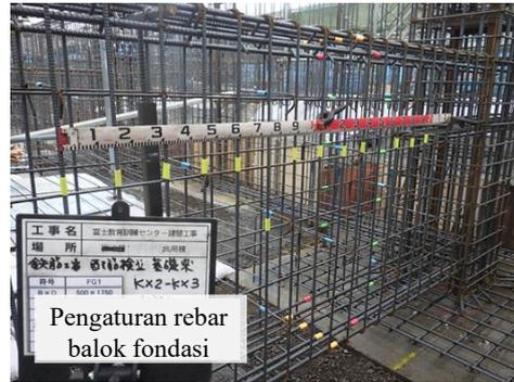
tegak lurus terhadap tanah dan sendi lingkaran (pengikat) yang mengelilingi rebar utama. Setelah pengikatan sendi tiang dan sendi lingkaran selesai, pasang spacer untuk mengamankan ketebalan penutup. Setelah semua pengaturan rebar fondasi selesai, bekisting dipasang dan beton fondasi dicor.
