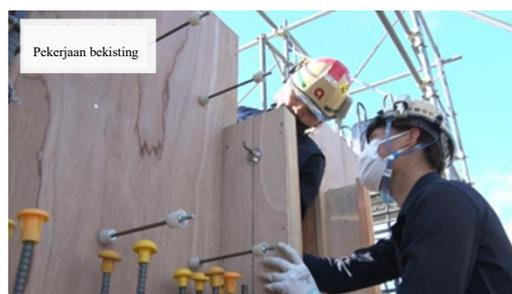
beton siap pakai mengalir keluar. Penguatan yang cukup untuk menahan tekanan beton diperlukan untuk mencegah pecah beton.
