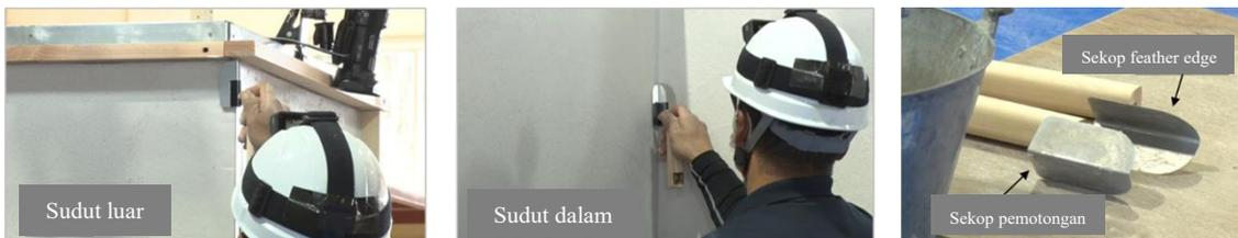
Dibandingkan pengecatan permukaan yang hasil akhirnya dapat dilihat, yang membuat perbedaan dalam keterampilan teknis adalah apakah alasnya dicat dengan hati-hati dan merata atau tidak. Pengecatan alas dasar secara langsung memengaruhi pengecatan hasil akhir.
