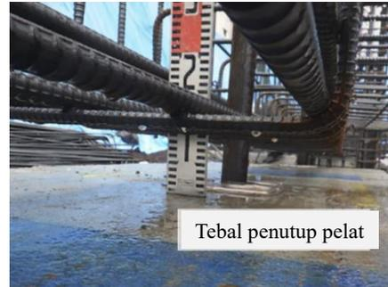
Oleh karena itu, saat menyusun rebar, penting untuk memiliki jarak tertentu di dalam dari permukaan beton, yang disebut “penutup”. Saat menyusun rebar, penting untuk memiliki jarak tertentu di dalam dari permukaan beton, yang disebut “penutup”.
