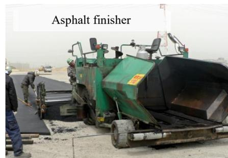
**[Pekerjaan lapisan permukaan]** Terakhir, aspal yang tahan lama, kedap air, dan tidak licin diletakkan secara merata dan dipadatkan.
