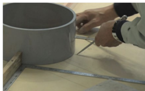
တိုင်လုံးအပိုင်းတွင် အမှတ်အသားပြုလုပ်ခြင်း
