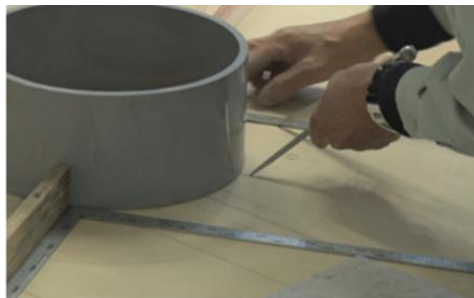
การทำเครื่องหมายบริเวณเสากลม
