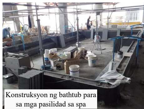
Gawain sa sealing waterproofing
