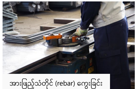
အားဖြည့်သံတိုင်(Rebar)ဆောက်လုပ်မှုအလုပ်
