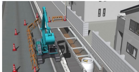
ရေဆိုးရေမြောင်း၏ လူဆင်းပေါက်(manhole) အလုပ်
