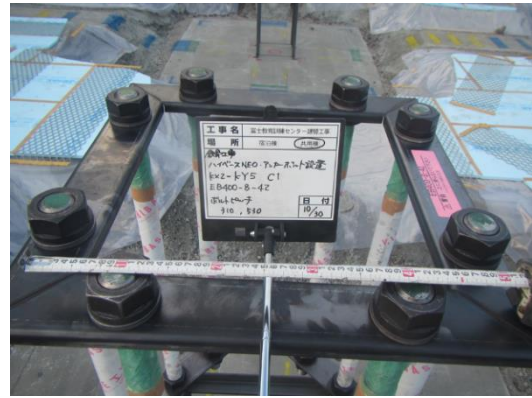
फोटो 2-1 निर्माण फोटोको उदाहरण
