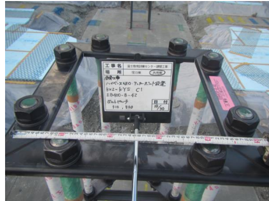
Ảnh 2-1 Ví dụ về ảnh chụp công trình
