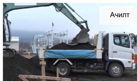
**[Дүүргэх, нягтруулах]** Талбайн хувьд бульдозероор далан хийж, нягтруулдаг. Налуу тал нь гидравлик экскаваторт налуу шанагыг бэхлэх замаар хэлбэржүүлдэг. Нягтруулах зориулалттай нягтаршуулдаг машинуудыг ашигладаг.
