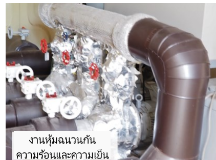
งานหุ้มฉนวนกัน ความร้อนและความเย็น
