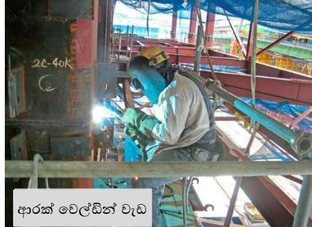
කිරීම, ගොඩනැගිලිවල රාමුව සාදන වානේ රාමු වෙල්ඩින් කිරීම සහ කළු රෘතුම් ඉදිකිරීම වැඩ වලදී තහවු පසිල් (වානේ තහවු) වෙල්ඩින් කිරීම කෙරේ. එය ඉස්කුරුප්පූ හෝ බෝල්ට්ට් ඇත් මගින් සම්බන්ධ කිරීමට වඩා හොඳින්, වාතය අනුළුවීම හොඳින් වලක්වන අතර සැහැල්ල විම ලක්ෂණ වේ. වෙල්ඩින් ක්‍රම බොහෝ ඇත, නමුත් ඒවා දළ වශයෙන් වර්ග තුනකට බෙදිය හැකිය. එනම්, උණුකර වෙල්ඩින් කිරීම, පීඩින වෙල්ඩින් කිරීම සහ මුළු වේ.
