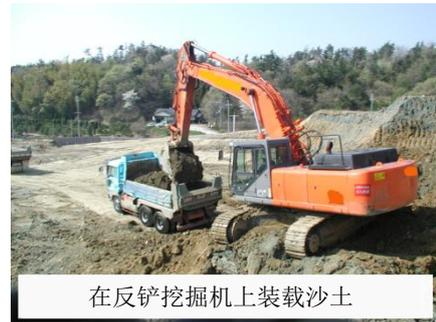
在反铲挖掘机上装载沙土
