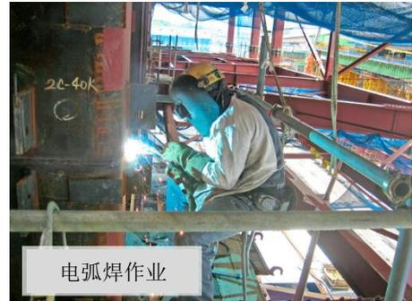
或螺栓接合，它的优点是气密性更高、更轻量。焊接方法有很多种，大致可分为3种类型：熔焊、压焊、钎焊。
