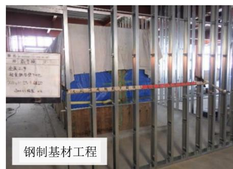
[贴板]将石膏板粘贴在钢制基材上。在石膏板上粘贴壁纸时，为了让石膏板接缝不那么明显，需要用腻子粉将接缝处抹平。
