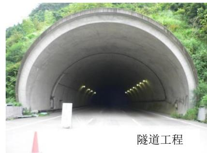
**[山岳隧道]**山岳隧道施工法主要通过在山岳地区挖掘坚硬岩石以开凿隧道。山岳隧道采用称为 NATM 的施工法，使用爆破装置或隧道挖掘机等挖掘隧道，在开挖面上喷涂混凝土，然后安装钢制支架和锚杆以支撑隧道。
