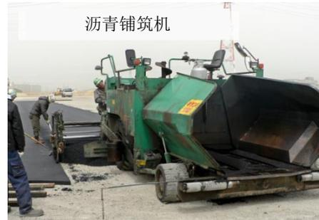
**[表层施工]**最后均匀铺设耐用、防水、防滑的沥青并压实。
