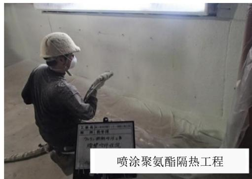
“喷涂聚氨酯隔热原液”由多元醇和多异氰酸酯两种成分组成，多元醇成分中配有催化剂、发泡剂、稳泡剂等添加剂。
