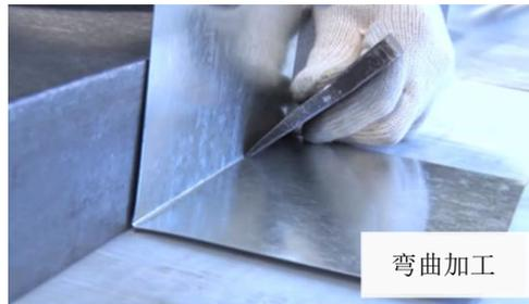
[**屋顶工程**] 在建筑物上铺设屋顶的作业称为“盖屋顶”。屋顶材料包括瓦片及其他多种类型，其中使用金属板材覆盖屋顶的作业属于建筑钣金工程。此外，为了保护建筑物免受屋顶落下的雨水侵害，必须有计划地排出雨水。这就是所谓的防雨工程。建筑钣金工程还负责加工和安装防雨工程所需的金属配件。
