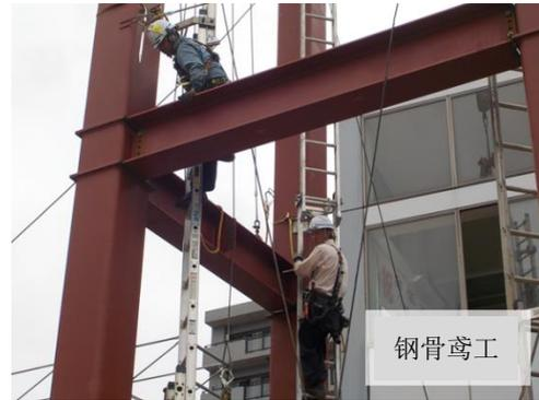
[**桥梁鸢工**]组装桥梁、水坝、铁塔、高速公路的钢骨。
