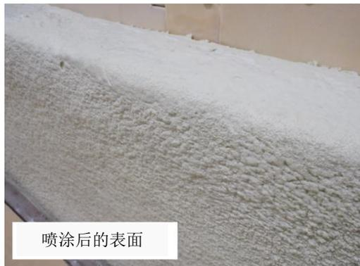
施工前将原液喷涂在边长约 450 毫米的正方形板材上，测试发泡密度。施工时，每隔 4 到 5 米用聚氨酯厚度测量机检查厚度。
