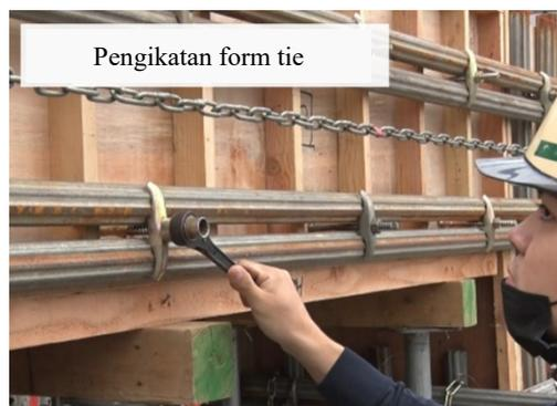
Untuk bekisting dinding, pemisah, form tie, P-con, dan bahan lainnya digunakan untuk memastikan tidak
