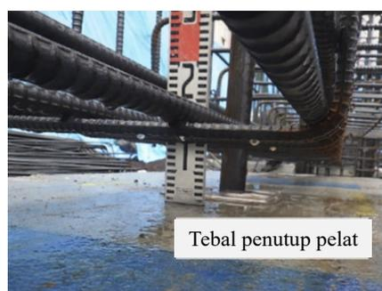
Untuk menjaga kekuatan, perlu menggunakan rebar dengan ketebalan yang ditentukan dan menyusun rebar dengan jarak yang benar di antaranya. Pita dililitkan di sekitar rebar untuk memudahkan memeriksa pitch.
