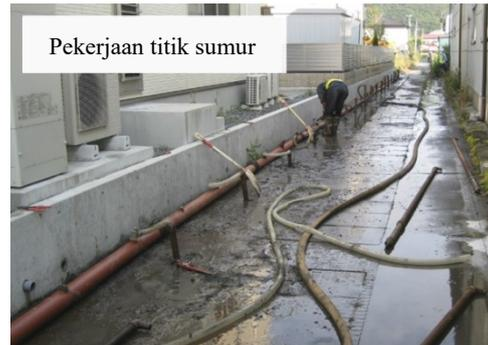
pemompaan air sampai pekerjaan yang diperlukan selesai. Setelah pekerjaan fondasi selesai dan pemompaan air dihentikan, aliran air tanah akan kembali ke tingkat air alami yang diperlukan untuk lingkungan setempat sebelum pekerjaan dilakukan. Metode konstruksi titik sumur merupakan metode konstruksi yang cocok untuk menyedot air pada kedalaman sekitar 2 m hingga 7 m. Jika lebih dalam dari ini, metode konstruksi yang disebut “sumur dalam” digunakan.
