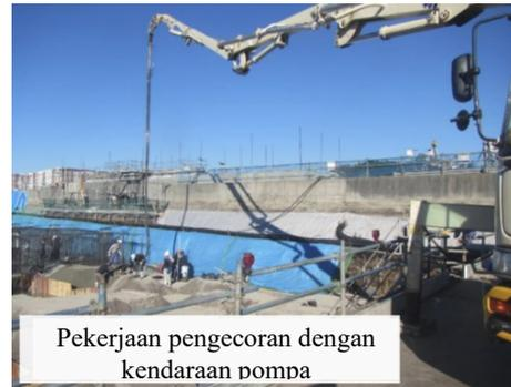
Selama pekerjaan berlangsung, yang harus diperhatikan adalah pergerakan boom agar tidak menyentuh atau memotong kabel listrik. Dalam hal kabel bertegangan tinggi, listrik dapat mengalir karena pelepasan percikan api meskipun tidak ada kontak langsung, dan Anda dapat terkena sengatan listrik. Periksa jarak aman (jarak jauh dari kabel listrik) dan patuhi ini.
