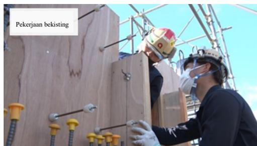
beton siap pakai mengalir keluar. Penguatan yang cukup untuk menahan tekanan beton diperlukan untuk mencegah pecah beton. Selain itu, karena terdapat risiko pecah beton saat beton dituang dari tempat yang tinggi, rapat terperinci juga dilakukan dengan vendor pompa beton tentang metode penuangan beton.
