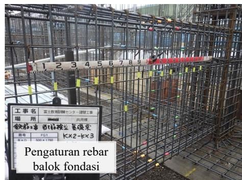
“Rebar dasar” diapungkan dengan blok spacer untuk mengamankan ketebalan penutup. Setelah
