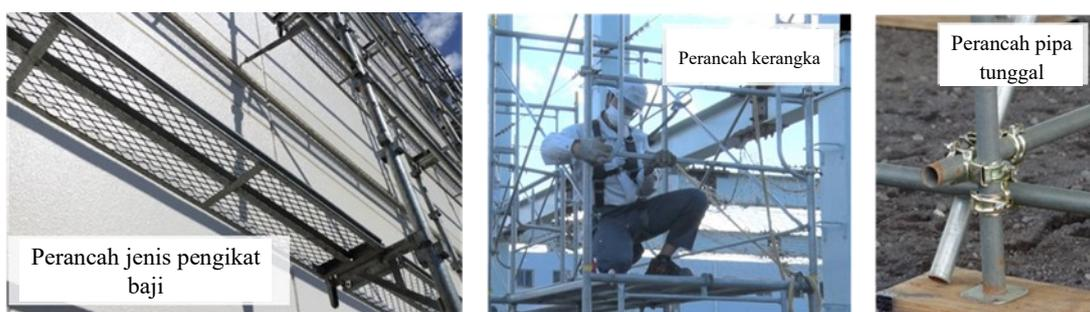
**[Pipa tunggal]** Pipa untuk perancah yang terbuat dari pipa baja berdiameter 48,6 mm.
