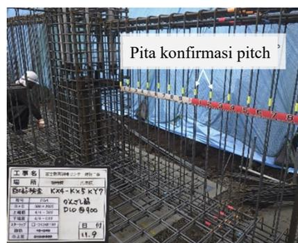
Untuk batang pelat tipis, rebar disambung menggunakan metode yang disebut “penyambungan tumpang”. Ini adalah metode penyambungan yang memperoleh kekuatan dari adhesi beton ke rebar, tetapi karena kekuatan beton berpengaruh, panjang tumpang tindih yang cukup diambil dan dikencangkan dengan kawat pengikat.
