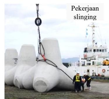
**[Pekerjaan crane]** Pekerjaan crane adalah pekerjaan mengangkat benda berat, memindahkannya ke tempat lain, dan menurunkannya di tempat lain. Crane pada kapal kerja digunakan untuk melakukan pekerjaan pengerukan, pekerjaan memasukkan batu puing, pekerjaan pemasangan balok, dll.
