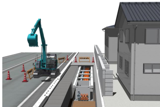
उपयोगिता पोल हटाउने निर्माण कार्य
