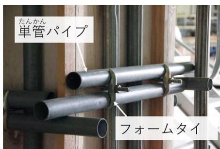
【単管パイプ、鋼管パイプ】型枠の強度を高めるために使用する部材です。単管は丸型、鋼管は角型です。
